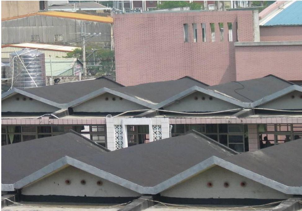
折板式屋頂，再加上防水隔熱，遮陽隔熱
