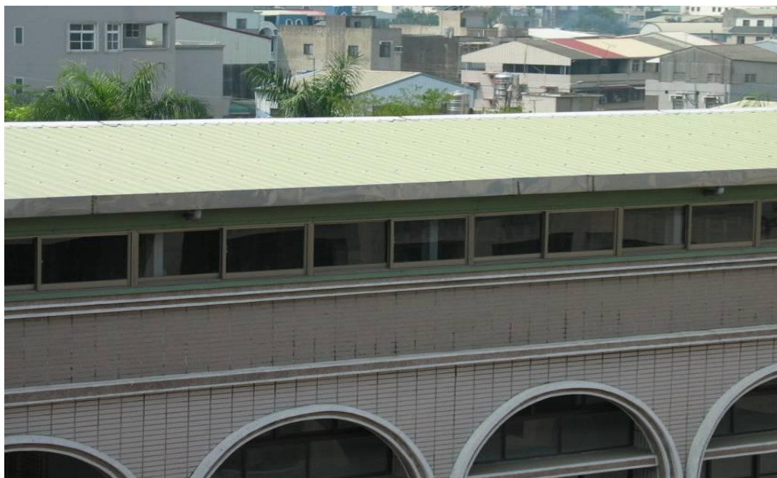
屋頂加蓋工程，遮陽隔熱
