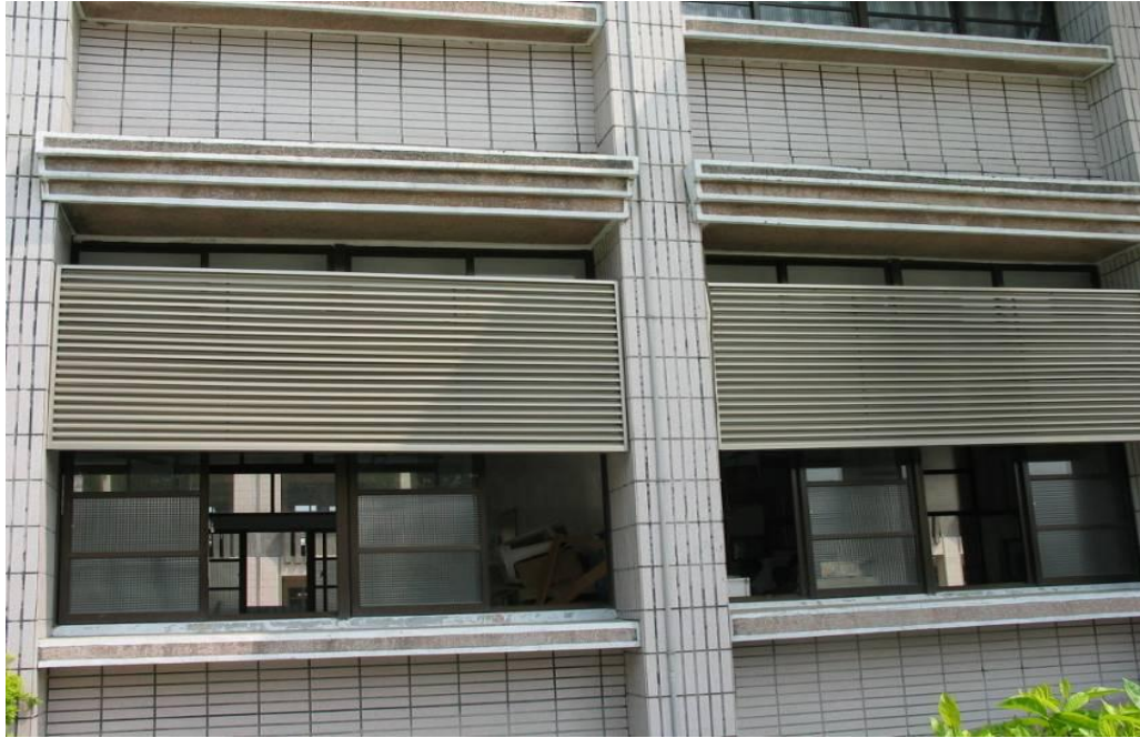
鋁柵欄遮陽隔熱
